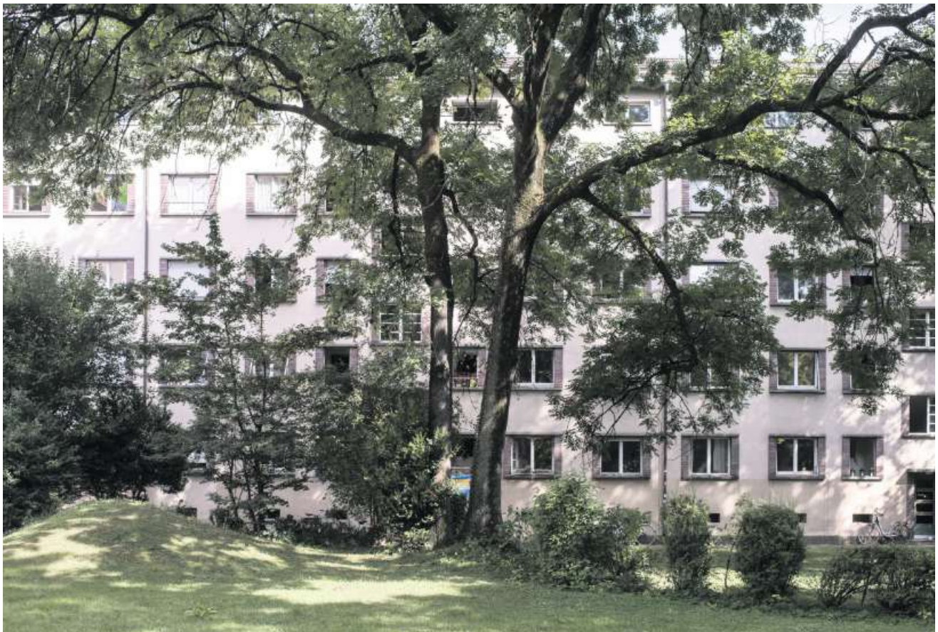
14 Jahre Planung ohne Resultat: Die Siedlung an der Seebahnstrasse sollte längst abgerissen und neu errichtet sein. SIMON TANNER / NZZ
