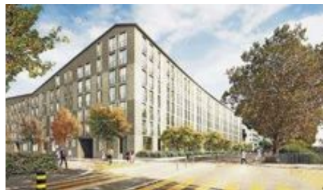
Die neue Häuserzeile der BEP. Sie soll als Erste und vor 2020 fertiggestellt werden. Visualisierungen: zvg.
